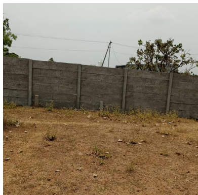
రోడ్డుపై నిర్మించిన అక్రమ నిర్మాణం
