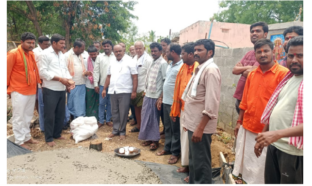
సీసీ రోడ్డు పనులను ప్రారంభిస్తున్న శ్రీనివాస్ రెడ్డి
