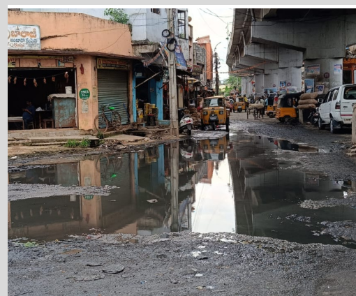
డ్రైనేజీ పేరుకుపోయి దుర్గంధంగా మారిన రోడ్డు
