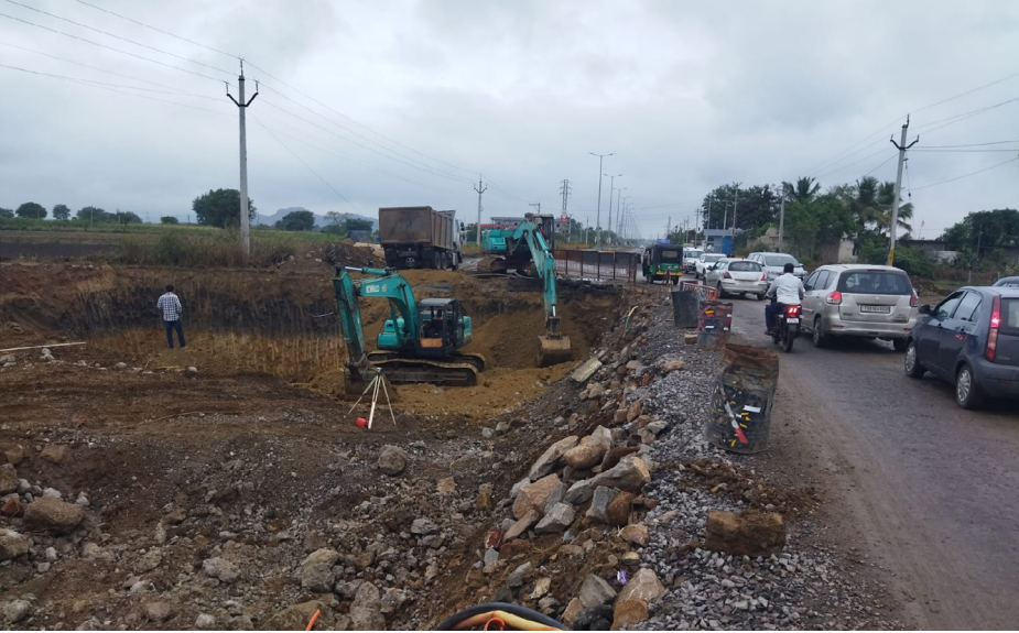
దామెర మండలంలోని ఓగ్లాపూర్ వద్ద ఎస్సారెస్సీ కెనాల్ పై వంతెన నిర్మాణానికి మొదలైన పనులు
