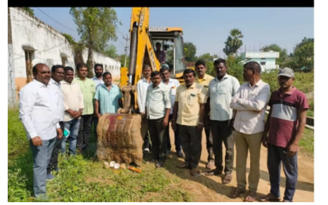
డ్రైనేజీ నిర్మాణ పనులను ప్రారంభిస్తున్న శ్రీనివాస్
