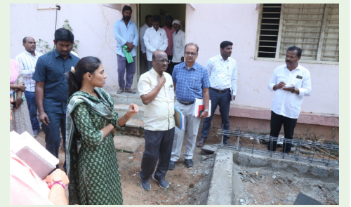
ఇందిరమ్మ ఇంటి నిర్మాణాన్ని పరిశీలిస్తున్న కలెక్టర్
