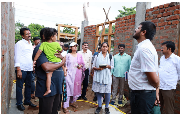
ఇందిరమ్మ ఇండ్ల నిర్మాణ పనులను పరిశీలిస్తున్న వీపీ గౌతమ్
